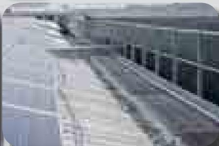
*Le passerelle non sono progettate per installarvi sistemi anticaduta con linee vita.*
